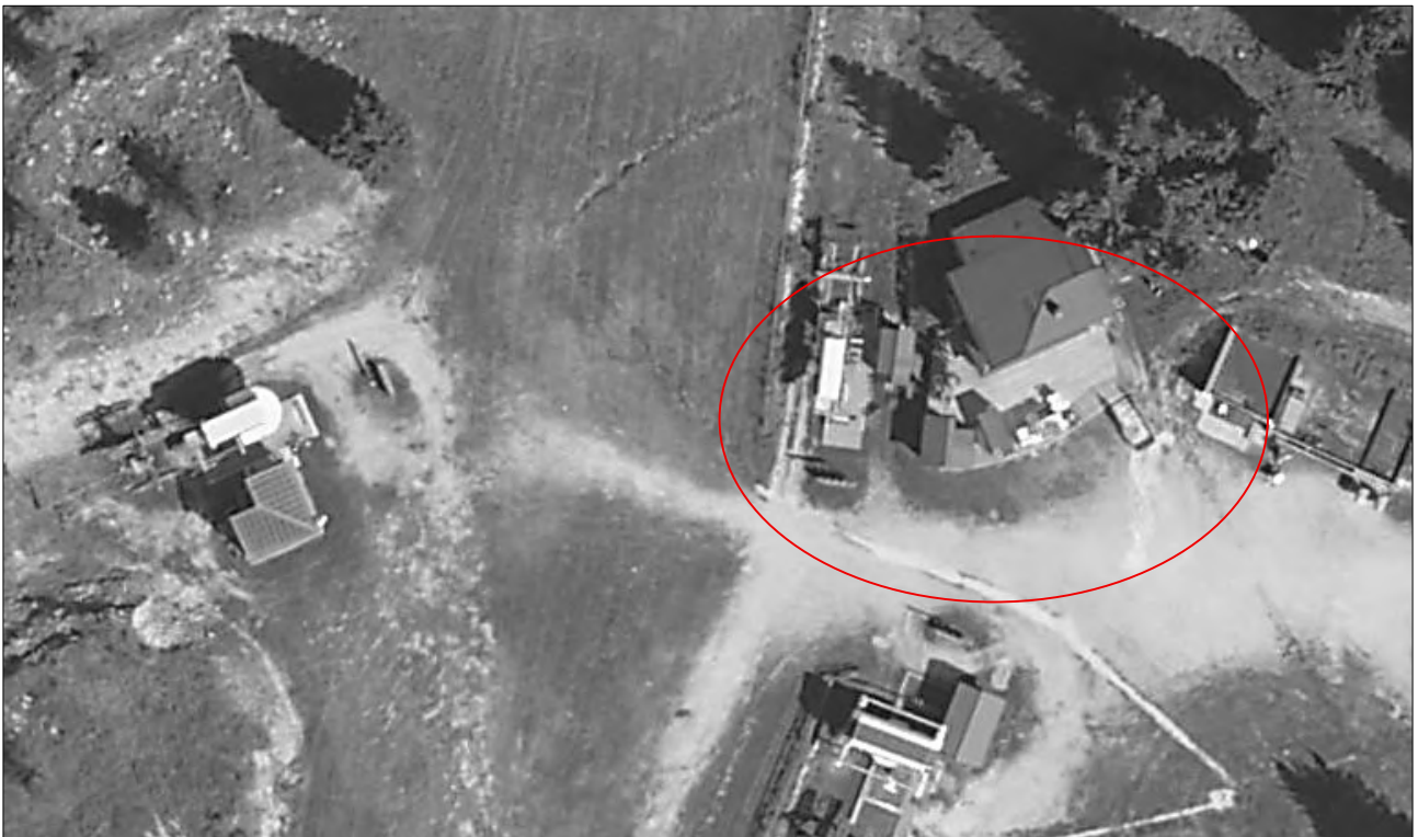
Area d'intervento presso area "La Busa"
