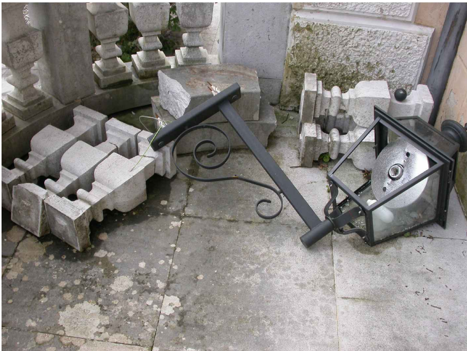
D_Colonnine della balaustra e lampioncino I danni alle colonnine sono riparabili. Il lampioncino deve essere rimesso in sagoma, riverniciato e ricollocato in opera.
